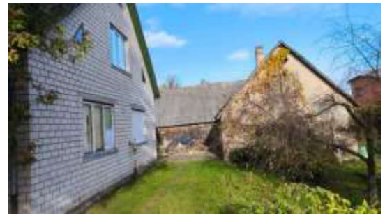
Dzīvojamā māja ar kadastra apzīmējumu 4052 009 0095 001, saimniecības ēka ar kadastra apzīmējumu 4052 009 0095 002, šķūnis ar kadastra apzīmējumu 4052 009 0095 003
